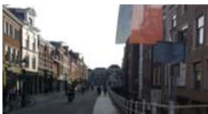
Het hekwerk langs het water
